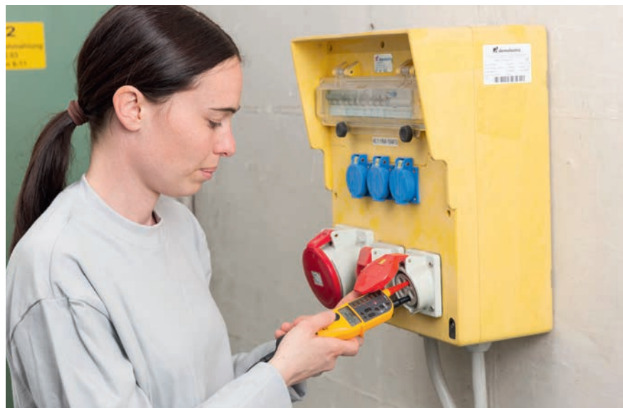
Bild 4 Messung bei einer Steckdose IP2X ohne PSA.
