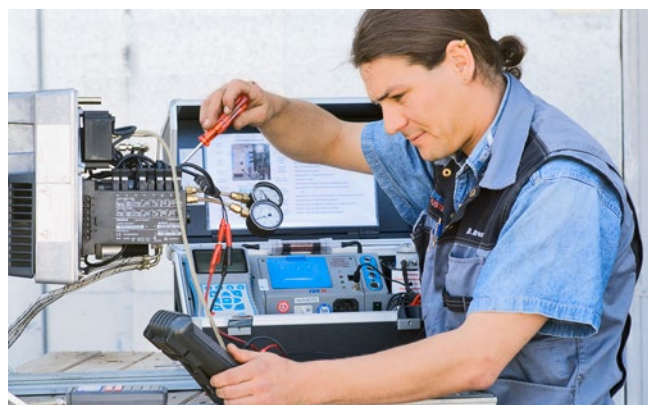
FIG. 2] Verifica di un bruciatore.
